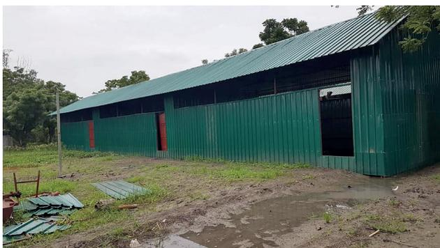
Die Comboni-Missionare haben mit dem Wachsen der Schule immer mehr Klassenräume auf dem Pfarrgelände gebaut und sind bereit, weitere Räume entstehen zu lassen. Sie wählen die günstigste Bauweise, bei der die Wände und das Dach aus Metallblech sind.
